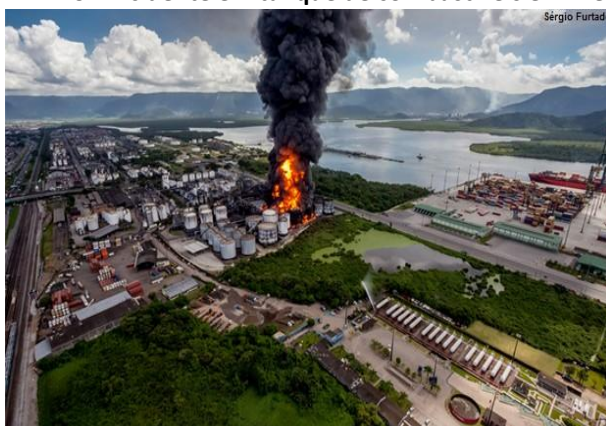
Figura 3.2.2.1.4-9 – Acidente em tanque de combustíveis em Alemoa, 2015
