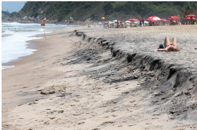
Figura 3.2.2.1.4-12 – Erosão na praia do Tombo – Guarujá, SP
