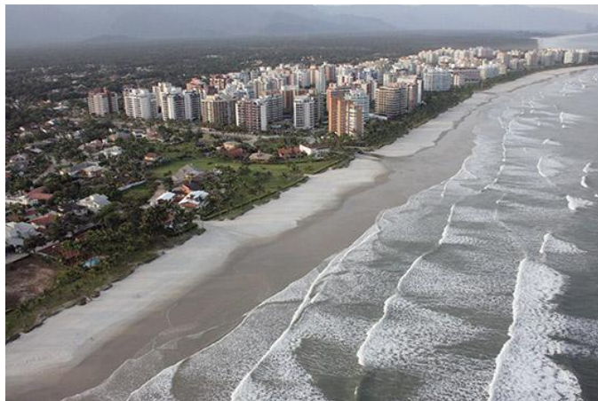
Figura 3.3.1.1-3 – Condomínios na Riviera de São Lourenço, município de Bertioga
